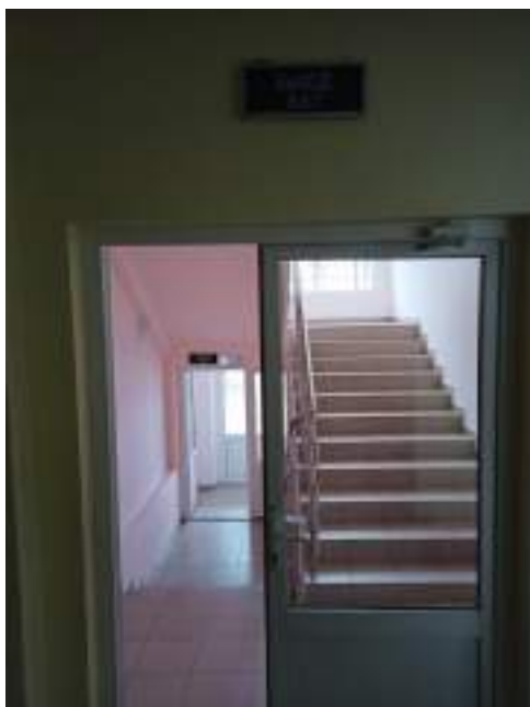
Фото № 17,18 (лестница (внутри здания))
