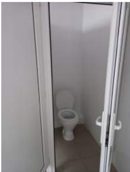
Фото № 19,20 ( туалетная комната)
