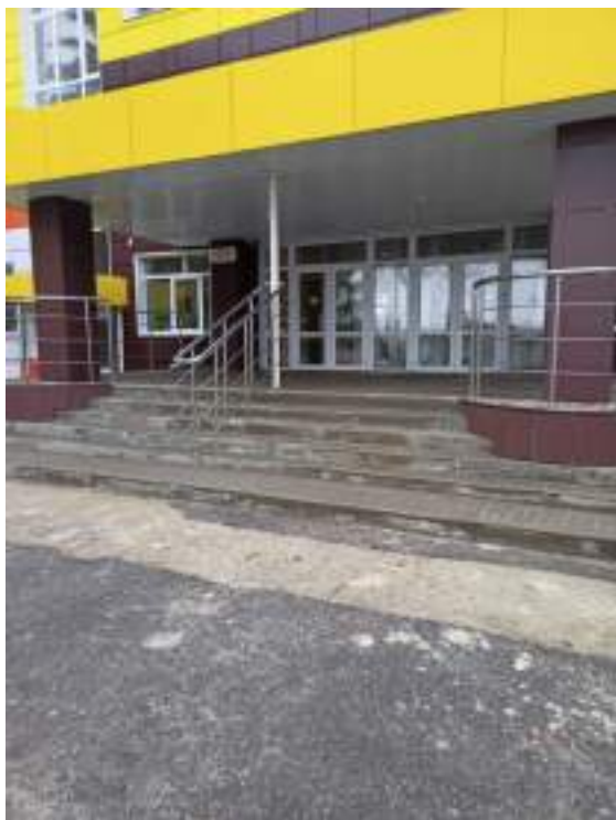
Фото № 5,6 (лестница (наружная))
