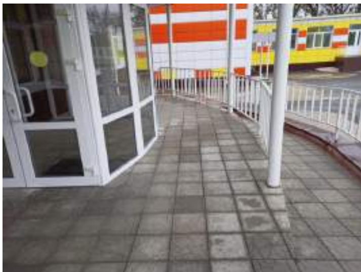
Фото № 9,10 (Входная площадка (перед дверью))
