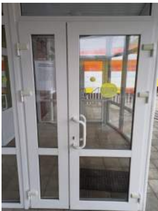
Фото № 11,12 ( дверь (входная))
